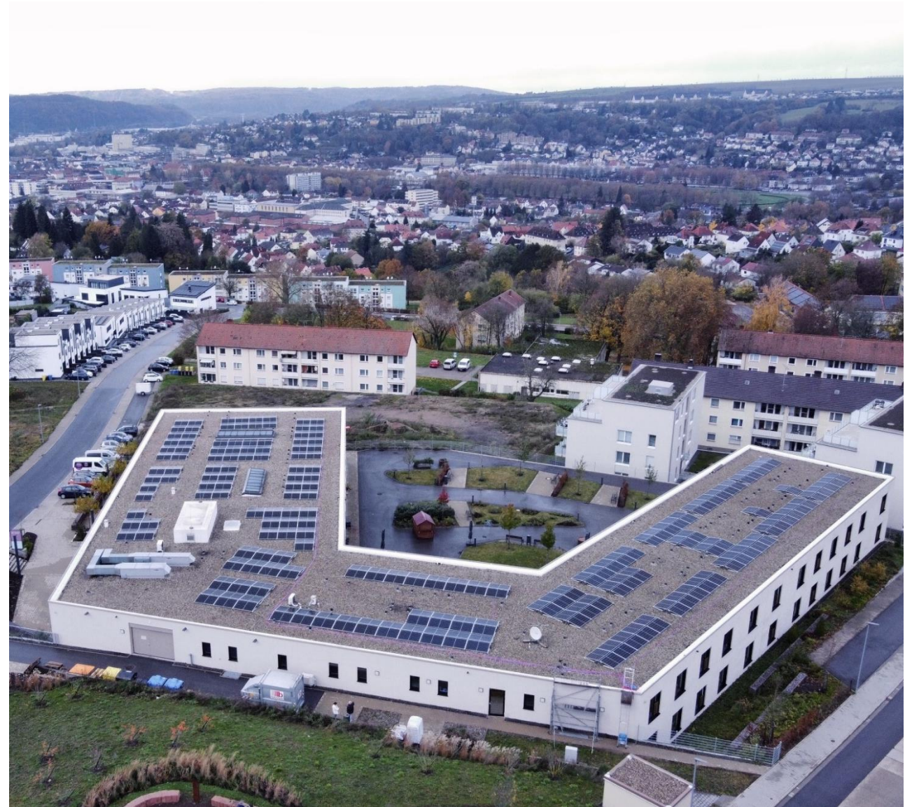
Erste PV-Anlage der BEG: 150 kWp auf Haus Kana in ZW
